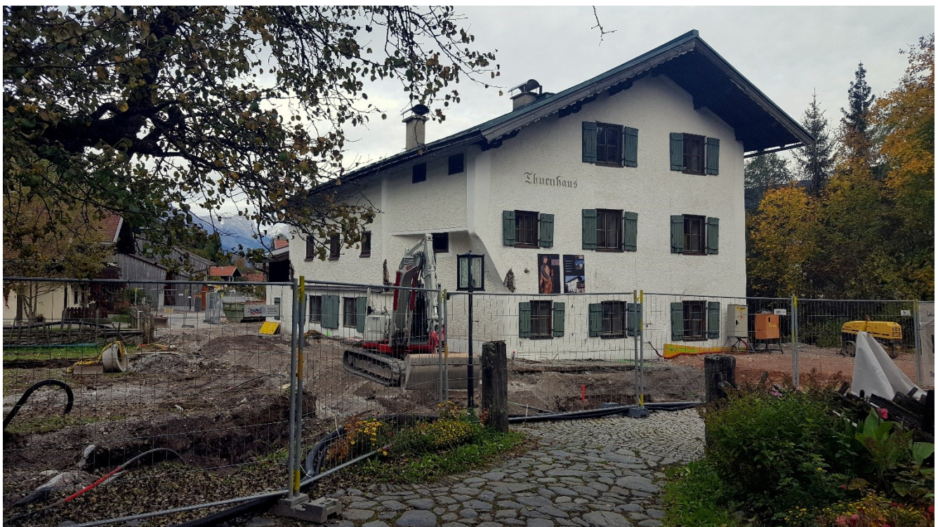
5. Oktober 2017 – erster Schritt: unterirdische Verbindung zwischen bestehendem Museum und Thurnhaus
